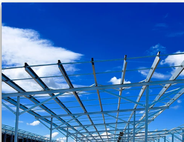
Ombrière de type 1 Avant la pose des panneaux
